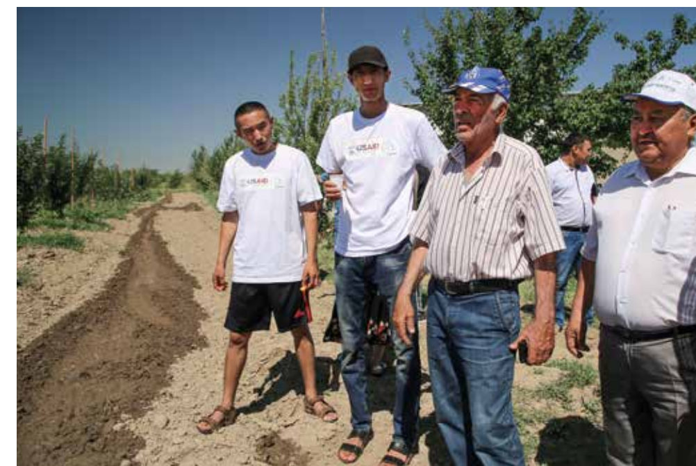
Члены МБС знакомятся с системой капельного орошения в одном из местных хозяйств, установленной в рамках проекта Smart Waters
