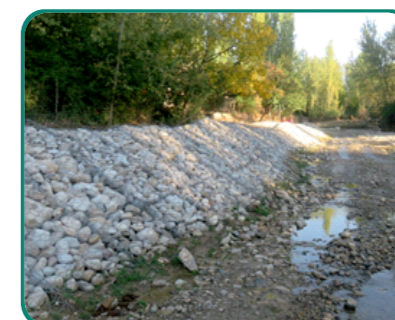
Защитные дамбы системы р. Исфана
