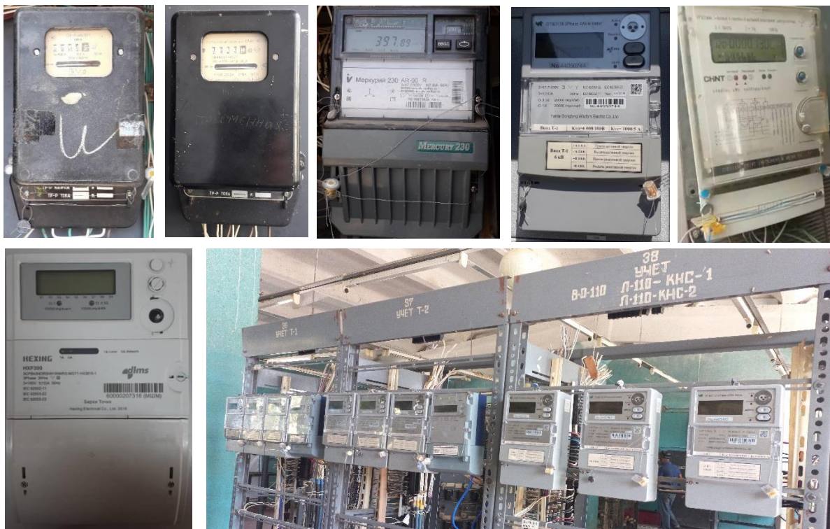
Рисунок 15. Слева направо. Счетчики марки САЗУ-И670М, СА4У-И672М, Меркурий 230, DTSD-178, DSS(x)666 и HXF300, а также ряд счетчиков марки DTSD-178 на подстанции Зафарabadского района
