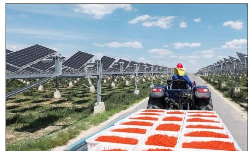
В решении «Huawei» используется технология горизонтального одноосного автоматического слежения, позволяющая солнечным панелям отслеживать солнце, как подсолнух, что, в свою очередь, значительно повышает эффективность выработки электроэнергии по сравнению с традиционными **фотоэлектрическими** электростанциями. Панели установлены на высоте **2,9** м, что дает достаточно места для выращивания ягод годжи и обеспечивает оптимальную эксплуатацию и техническое обслуживание.
