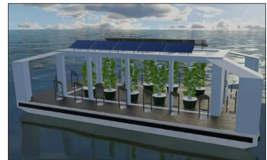
Технология дистилляции может производить пригодную для использования воду, улавливая потерянную испарившуюся воду из океана. Новый подход работает путем размещения большой конструкции, похожей на теплицу, а затем использует солнечные лучи для нагрева и испарения воды. Водяной пар конденсируется, когда он касается более холодной стороны конструкции, прежде чем он будет собран и сохранен в виде дистиллированной воды.
