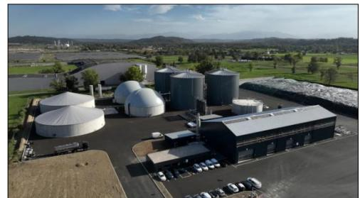
Для получения биометана на полигон будет поступать 220 тыс. тонн органических отходов. На первой стадии сырье нагревается до 70 градусов в течение одного часа, чтобы удалить патогенные микроорганизмы. Затем подготовленная масса подается в метантенки, где его перемешивают и нагревают до температуры
