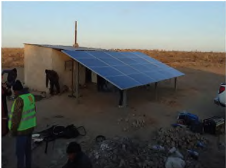
F) Solar panels
