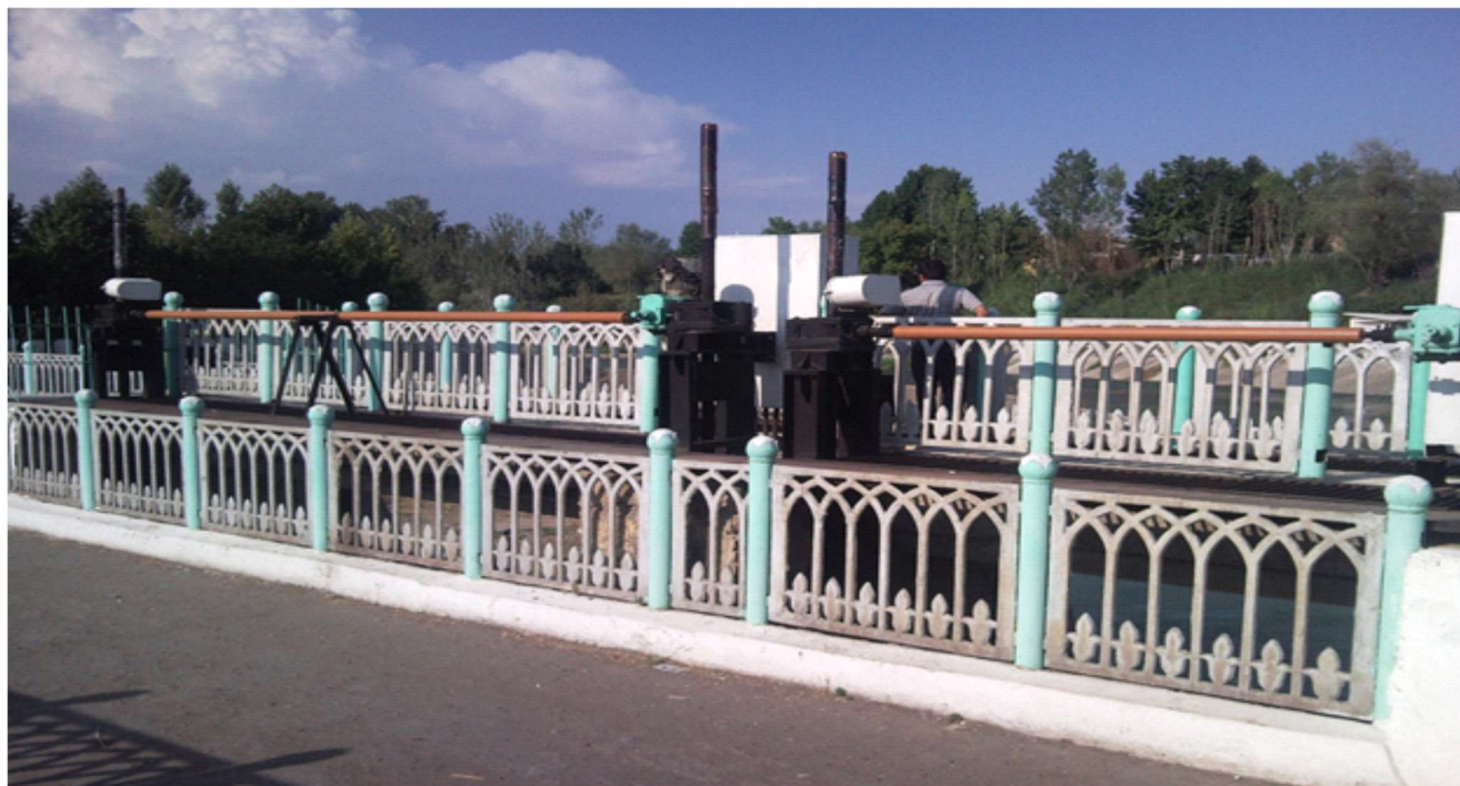
Рисунок 5: Гидроузел Тешик тош на реке Падшаата.
