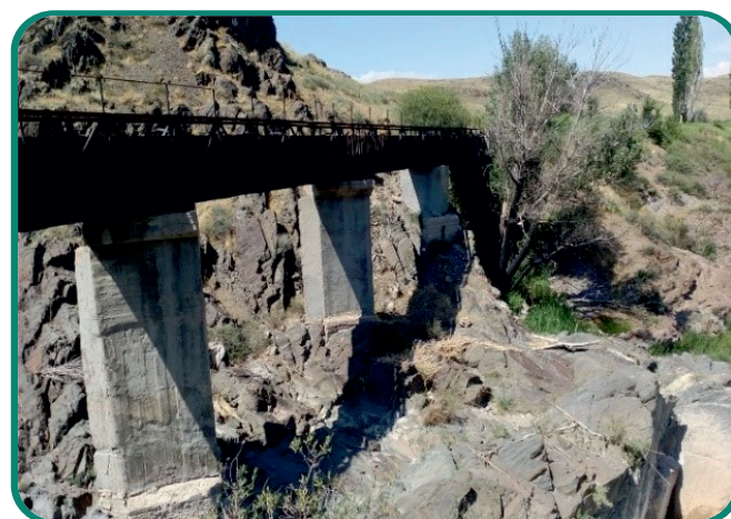
Переход трассы канала Раис через русло р.Асса
