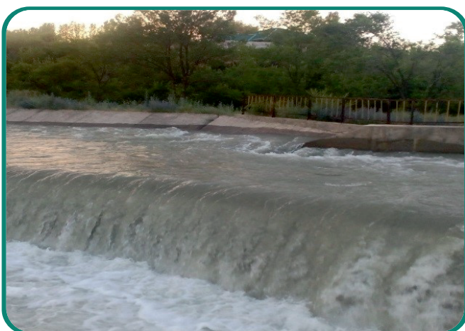
Водозаборное сооружение канала Каратакы
